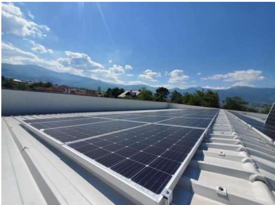
Слика 4. 9. Поставените панели како и начинот на нивното поврзување
