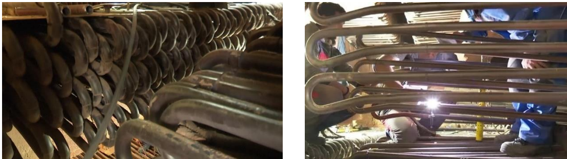
Слика 3.2 Примарен и секундарен прегревач на пареа
